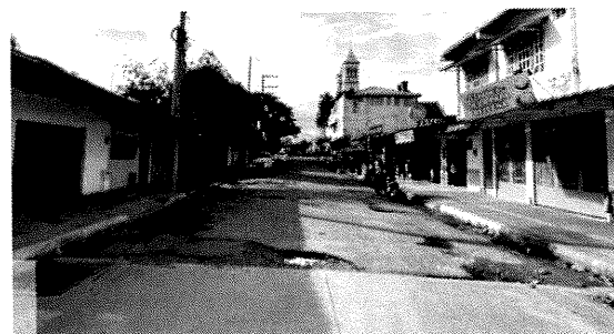
Tramo del corredor vial de la carrera 6 entre calle 12 y calle 11
